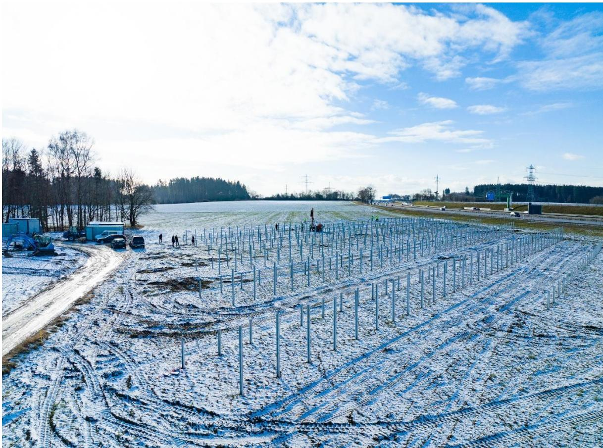
Rammarbeiten für die Errichtung der Unterkonstruktion der Photovoltaikanlage der Sonnenenergie Gilching GmbH & Co. KG
